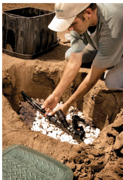
Inštalácia ventilovej šachty
